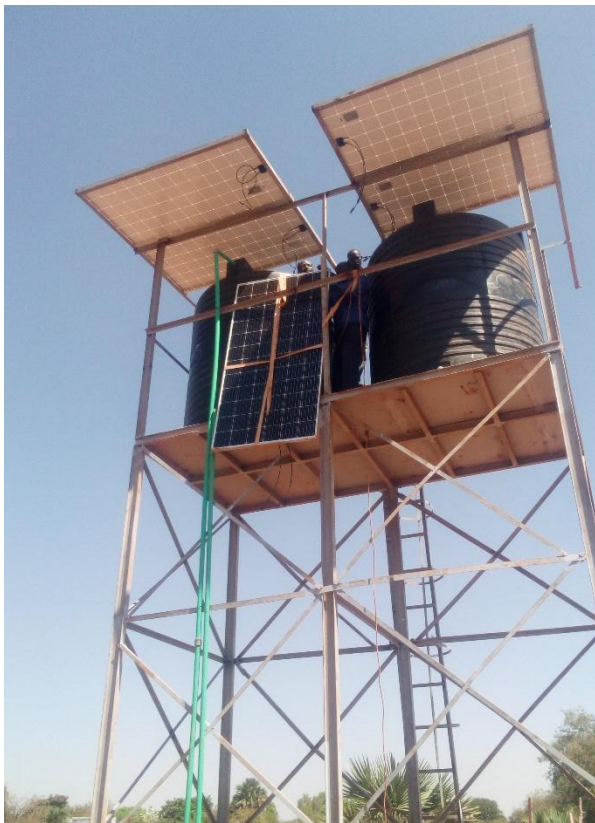
Kormaye: Montage der Solarpaneele
